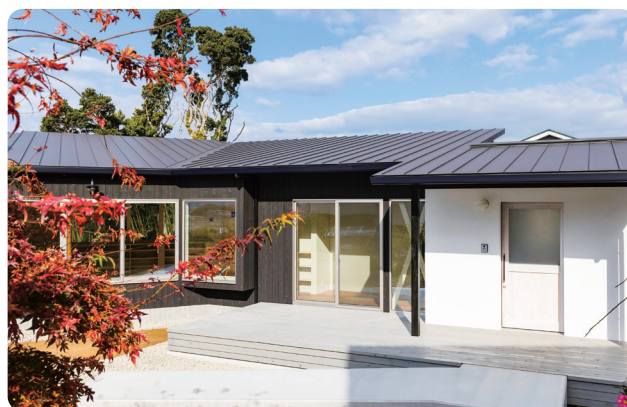
#6 外壁材は 日本の伝統的な焼杉と漆喰
